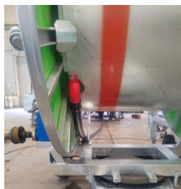
安装出水弯头
