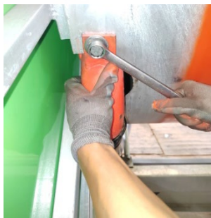
拆下出水弯头
